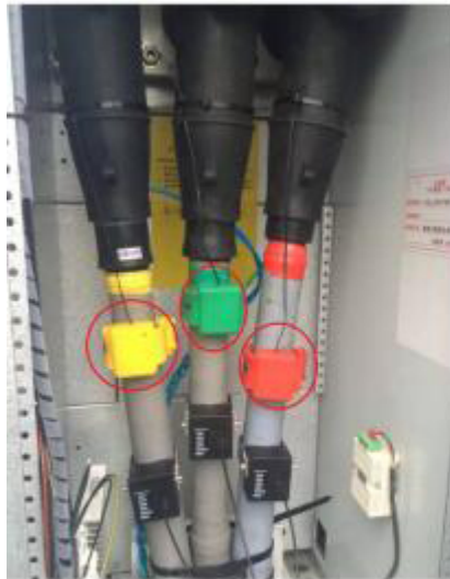
传统的安装方式 传感器安装于电缆外表
