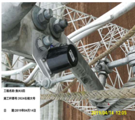
安装在 500kV 输电线路的引流板上
