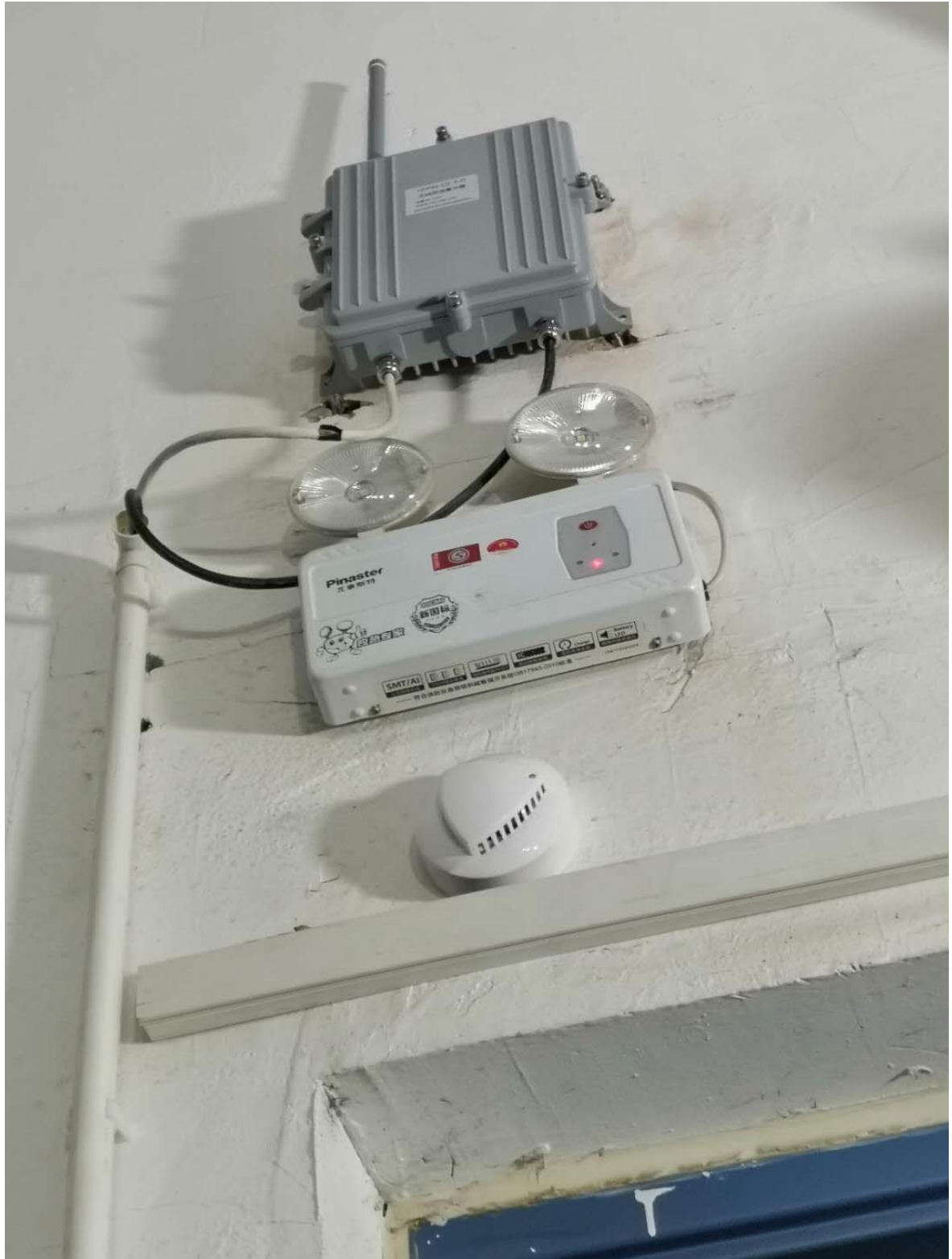
接收器安装在墙上
